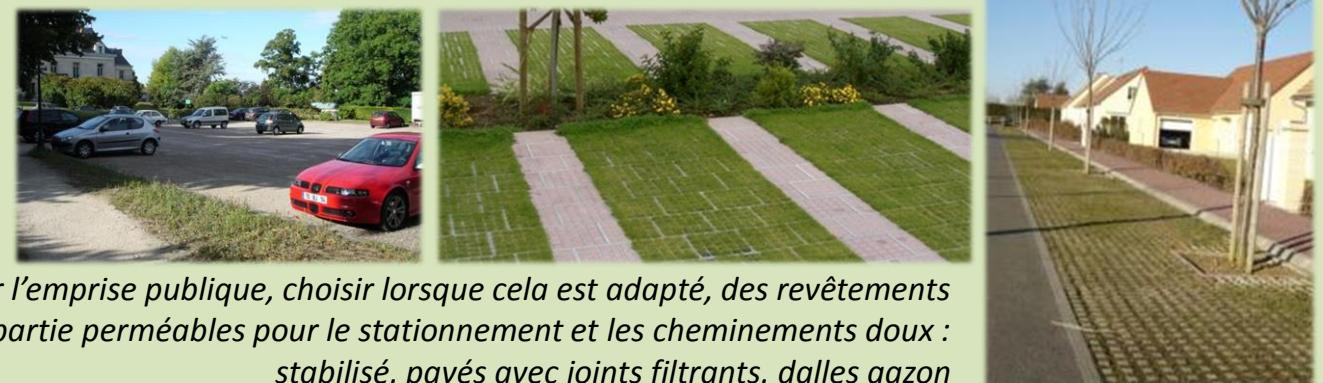
*Sur l'emprise publique, choisir lorsque cela est adapté, des revêtements en partie perméables pour le stationnement et les cheminements doux : stabilisé, pavés avec joints filtrants, dalles gazon*
