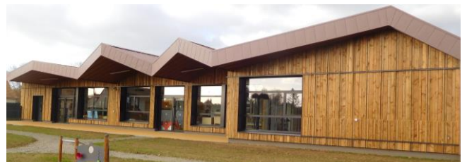
Structure Petite Enfance à Neuville sur Sarthe
